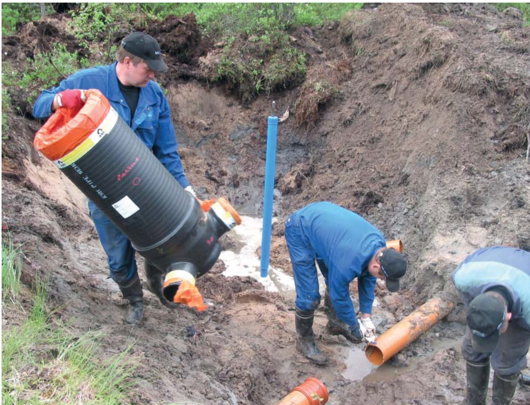
Viemärin tarkastuskaivoa asentamassa Jarkko Häkkilä, Timo Haapala ja Erkki Leinonen.
