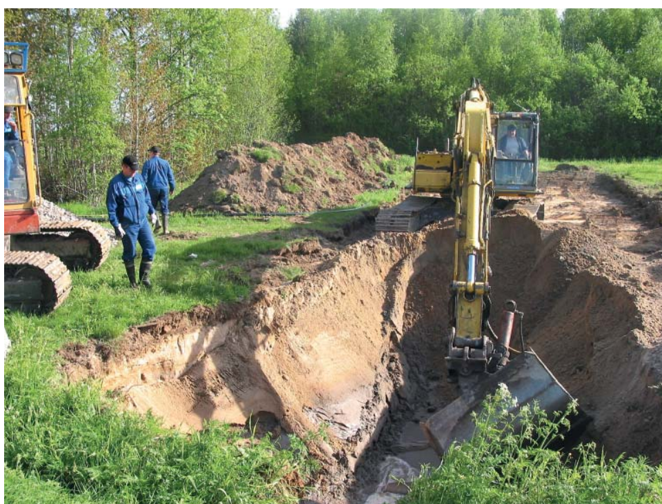
Putkikaivanto tulossa tietä kohti.
