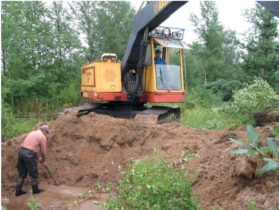
Asentaja Erkki Leinonen ja kaivinkoneenkuljettaja Matti Honkamaa etsimässä vesijohdon vuotokohtaa.
