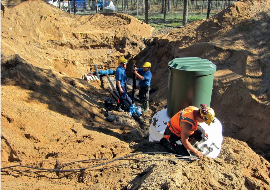
Vartinvaaraan mittakaivoa asentamassa Tuomo Soukka, Matti Honkamaa ja Niskasen Maansiirto Oy:n asentaja.
