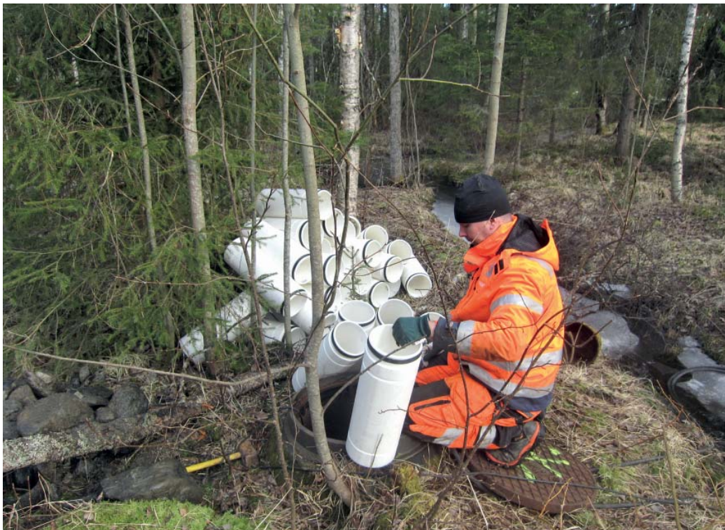
Viemäriä saneerataan pätkäsujutusmenetelmällä. Uponor Infra Oy:n asentaja Kari Mattila laskee putkenpätkiä kaivoon, jossa toinen asentaja liittää pätkät yhteen ja sujuttaa viemäriin.
