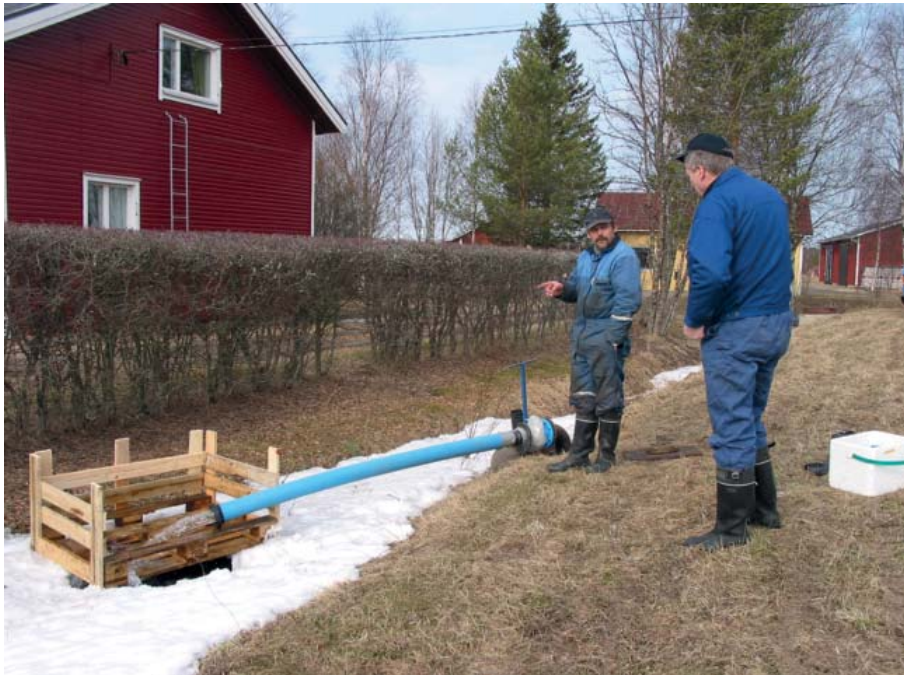
Runkoputkessa juoksevaa possua odottavat Matti Honkamaa ja Hannu Kähkölä.
