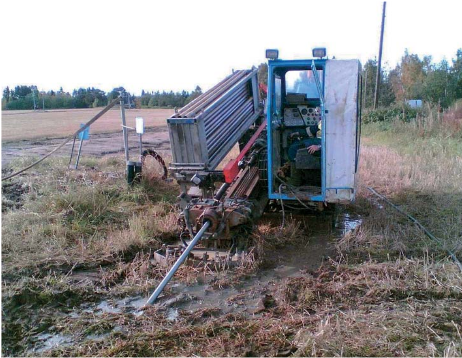
Paineviemärin tienalitusta tehdään suuntaporauksella Siikajoella.
