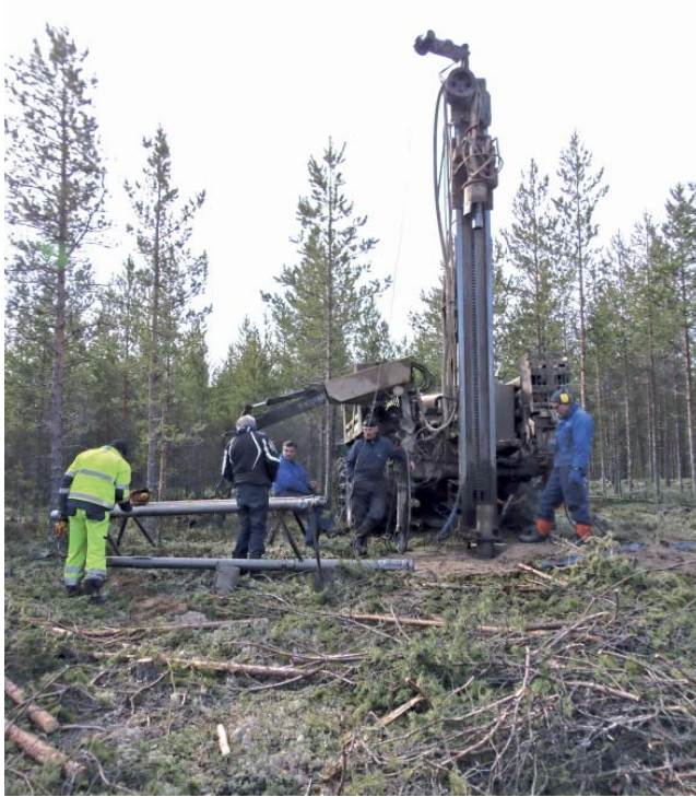
Siiviläputkia porataan maahan Vartinvaarassa.
