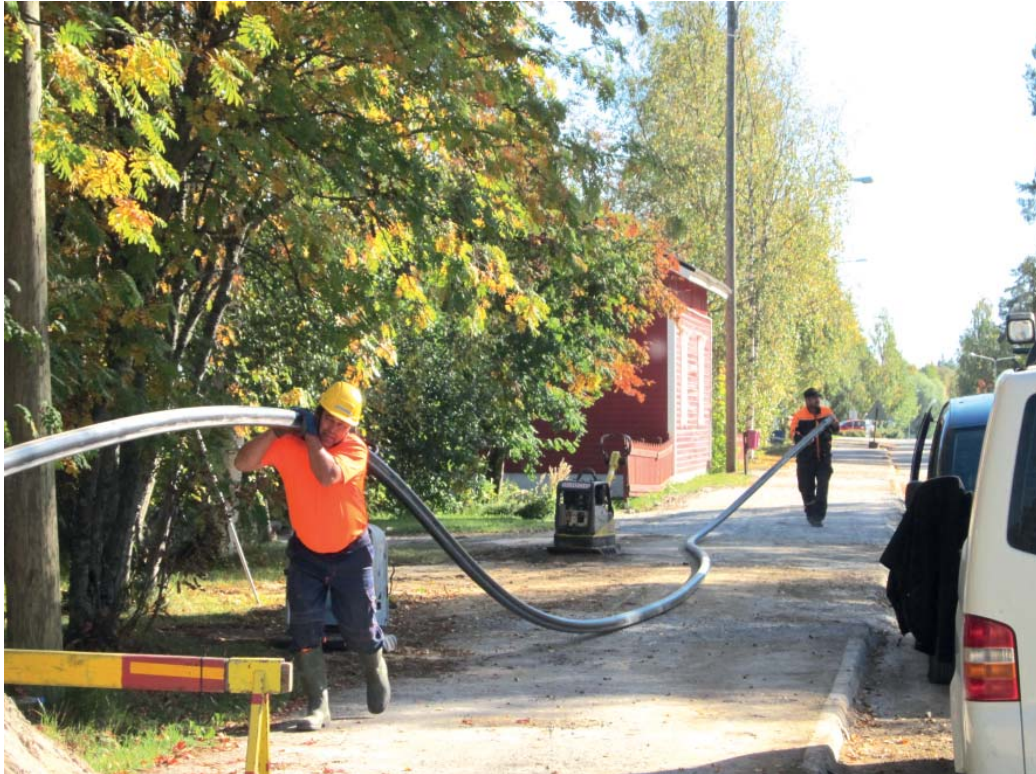
Uutta vesijohtoa viedään sujuttajalle monttuun. Kantajina Timo Haapala ja Juha Mustonen.
