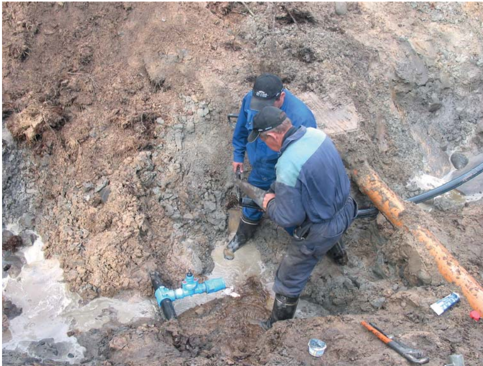
Vesijohdon liitosta rakentamassa Erkki Leinonen ja Timo Haapala.
