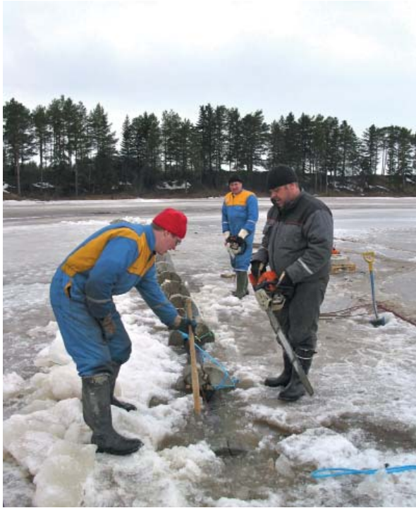
Sitten painellaan putki kohti pohjaa.
