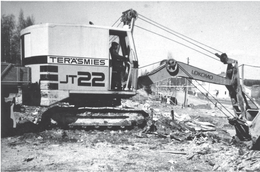
1960-luvun lopussa kaivinkoneet olivat vielä vajerikoneita. Nykyisiin hydraulikkakoneisiin verrattuna ne olivat tehottomia ja herkkiä rikkoontumaan. Vesijohtotyömaan pöytäkirjoissa onkin tämän tästä merkintä: "Vajeri poikki." (Kuva: Työväenmuseo Werstaan kuvakokoelmat)
