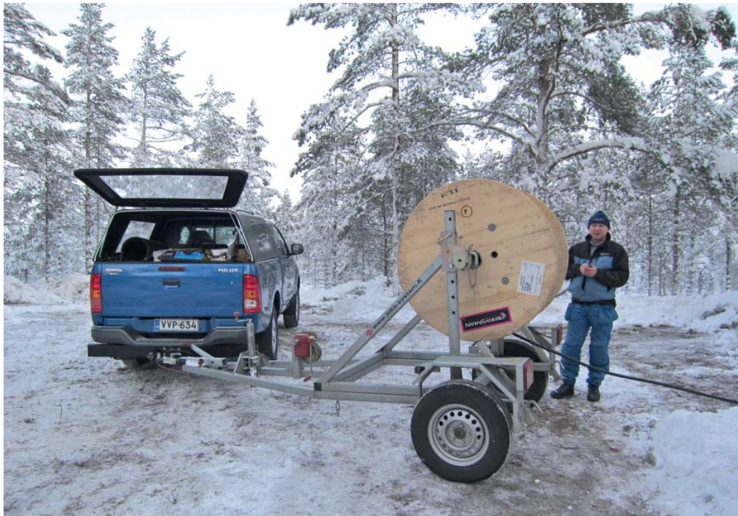
Koepumppauspaikalla tarvitaan sähköä. Sitä tuomassa Kari Kuusisalo Oy:n asentaja Lauri Alatalo.
