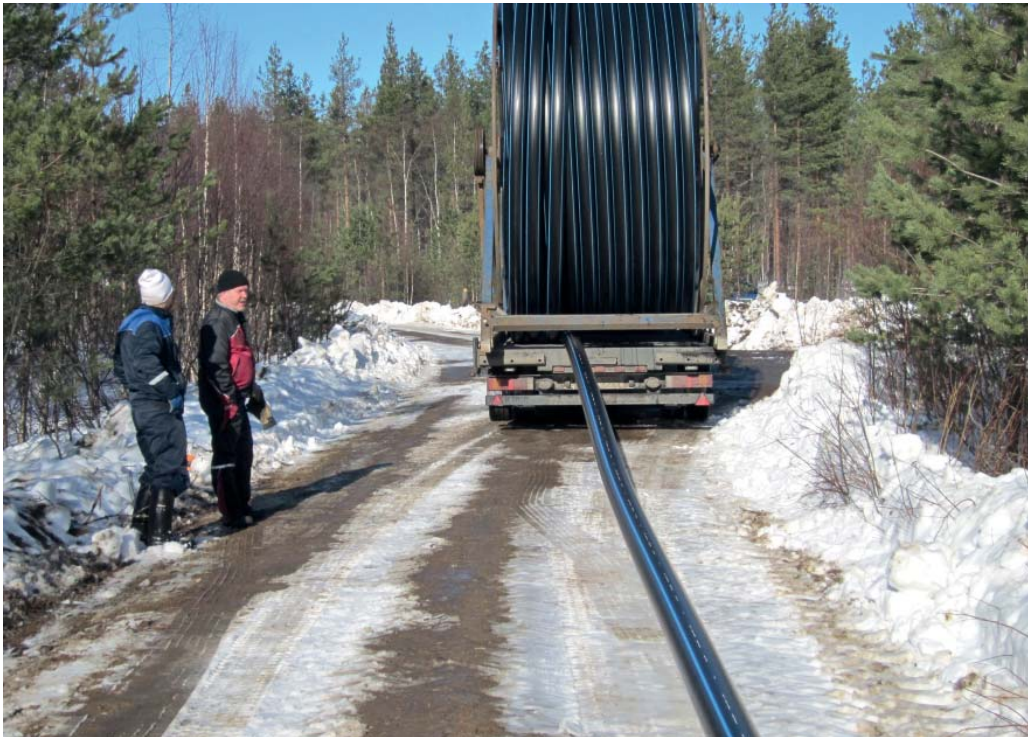
Vesijohtoputkea puretaan kuljetuslavetilta. Menossa on Koivula 1 - Revonlahti -vesijohdon saneeraus.
