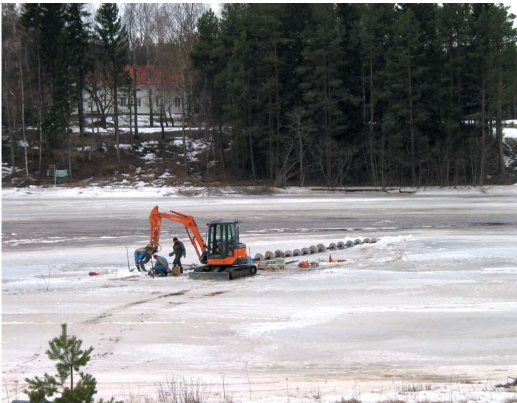
Paineviemärin joenalitusta rakennetaan Siikajoella.
