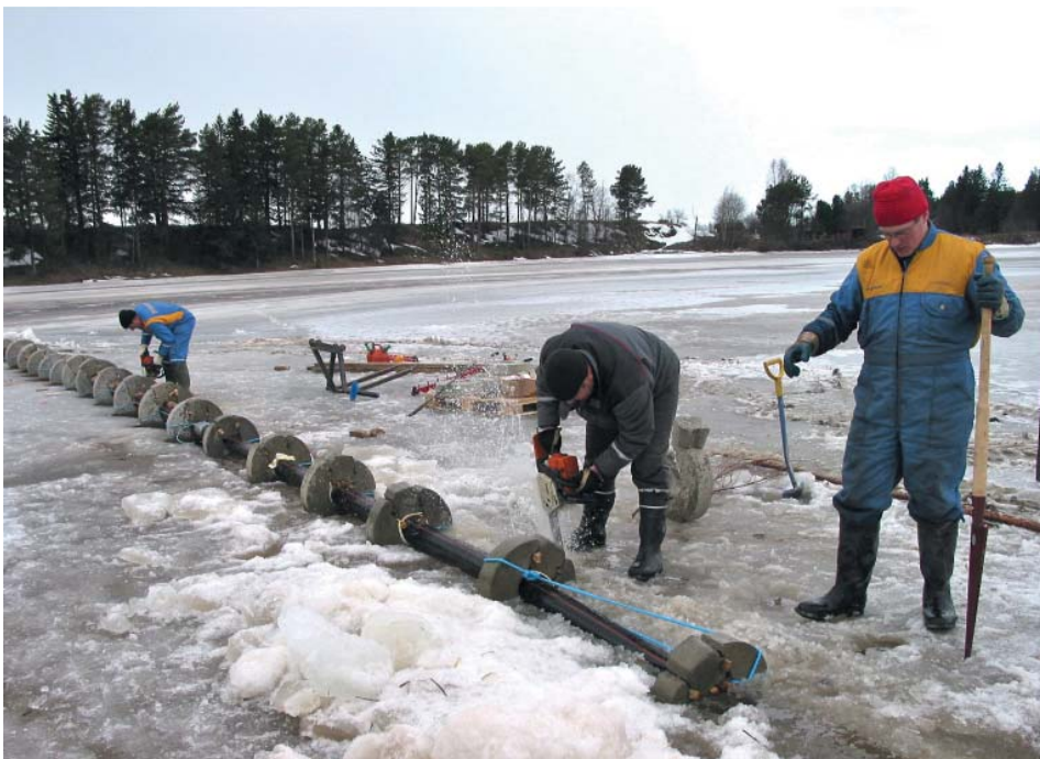
Siikajoen jäällä saha laulaa, kun Niskasen maansiirto Oy:n miehet korjaavat painevismäärin joenalitusta.
