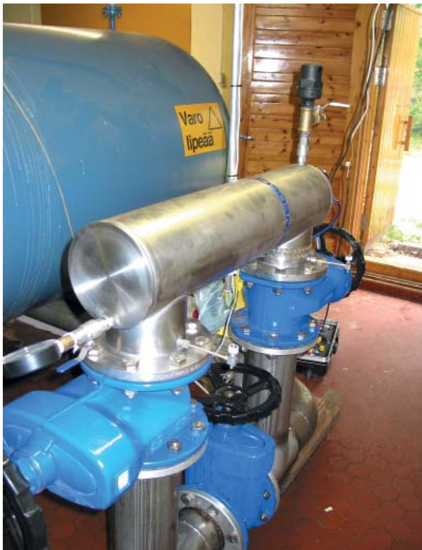
Vedenottamon laatutekniikkaa: uv-sterilisaattori ja lipeätankki. Lipeää eli natriumhydroksidia käytetään veden pH:n tasaamiseen..
