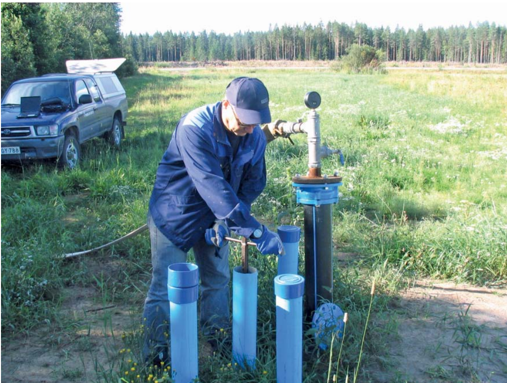
Vartinvaaran ja Karinkannan välinen uusi vesijohto otetaan käyttöön. Sulkuventtiiliä Karinkannassa avaa Seppo Rantoharju
