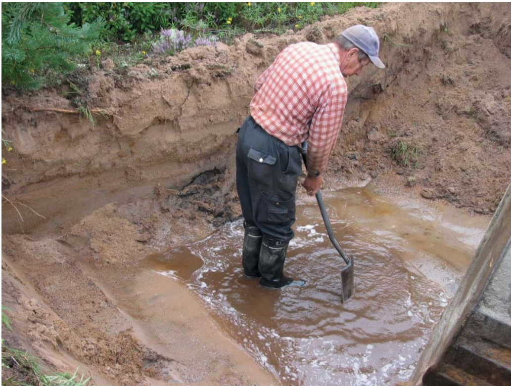
Kaikesta digitekniikasta huolimatta lapio on edelleen mitä tarpeellisin työkalu. Vuotavaa vesijohtoa montussa esiin kaivelee Erkki Leinonen.
