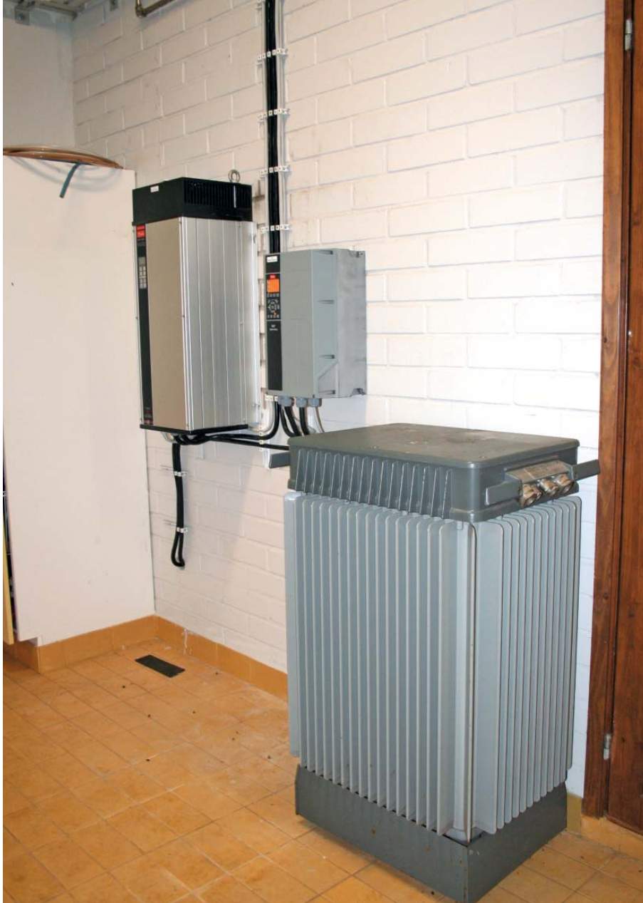
Kolmen sukupolven taajuusmuuntimia Keltalan vedenottamolla. Etualalla oleva suurin laite on yhtiön ensimmäinen taajuusmuuttaja. Seinällä oleva pienin on uudempaa mallia.
