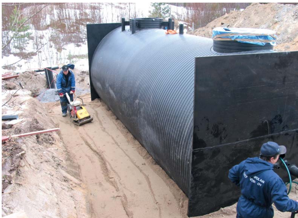
Siikajoen jätevedenpuhdistamolle asennetaan jälkiselkeytsallasta. Töissä Jouni Salmenkangas ja Pasi Alatalo.
