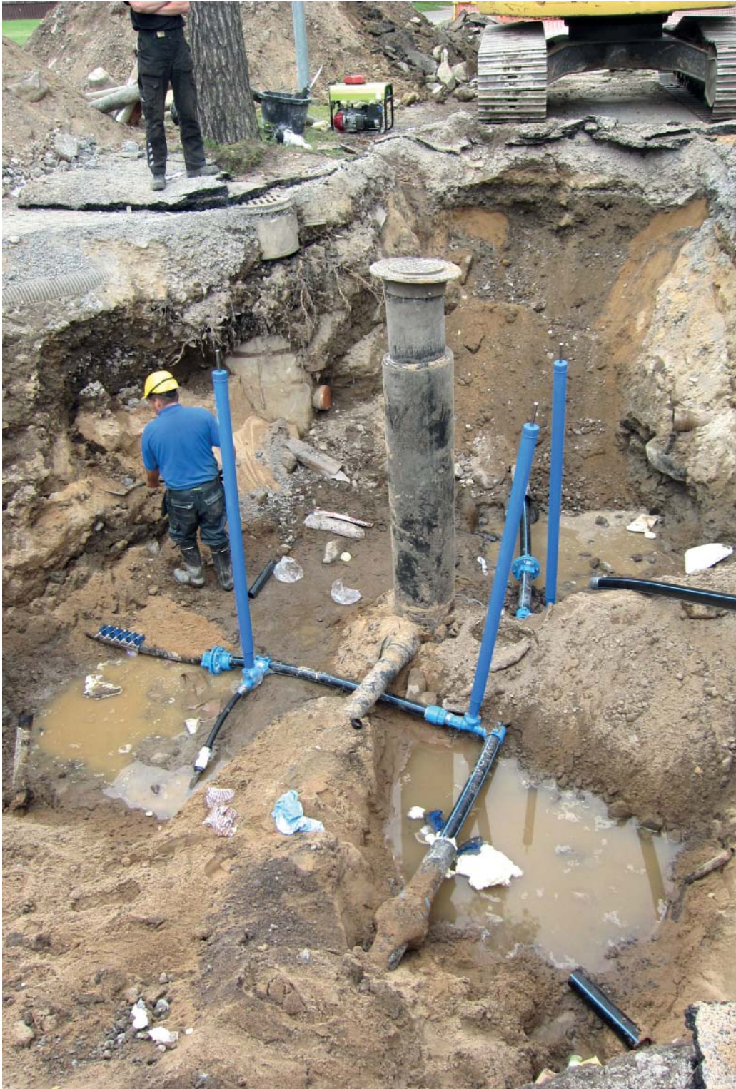
Vesijohtoa saneerataan Ruukissa. Montussa Matti Honkamaa.
