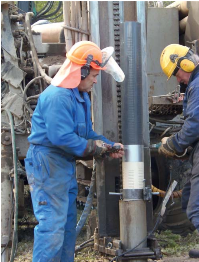
Siiviläputken ja jatkoputken liitosta rakennetaan.
