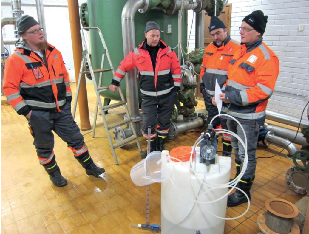
Veden kloorausjärjestelmän käytön harjoittelua Keltalan raudanpoistolaitoksella. Mukana Tuomo Soukka, Jouni Salmenkangas, Timo Haapala ja Seppo Rantoharju. Kloorausjärjestelmää käytetään vain poikkeustilanteissa jos verkoston joku osa on jostain syystä päässyt saastumaan.
