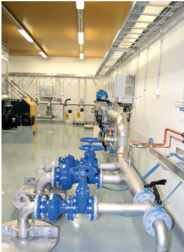
Vartin vedenkäsittelylaitoksen syöttöputkistoa.
