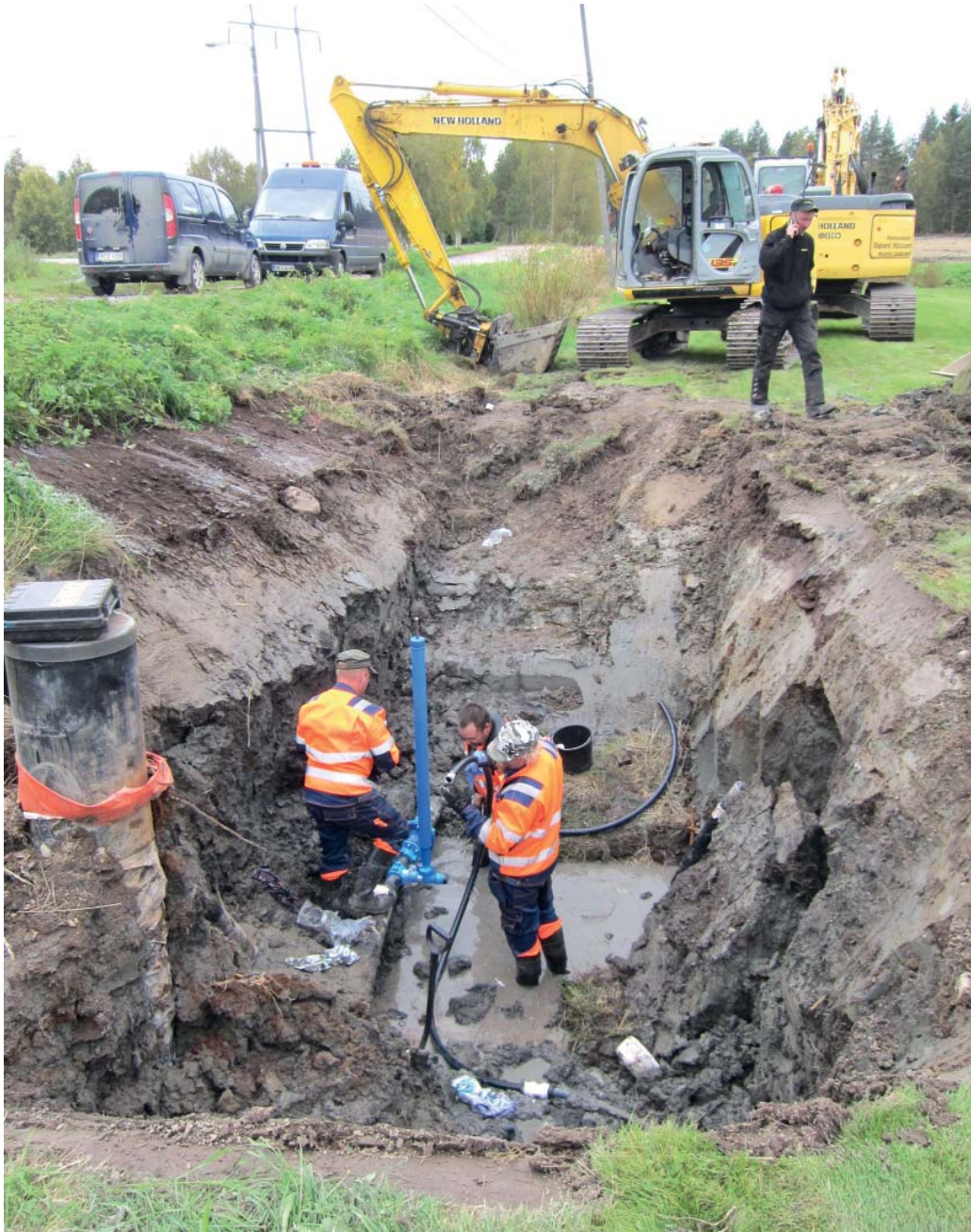
Vuotavaa vesijohtoa korjataan Ruukissa. Kaivannossa Jouni Salmenkangas, Matti Honkamaa ja Tuomo Soukka. Reunalla kävelee kaininkoneenkuljettaja Juhana Kulha.
