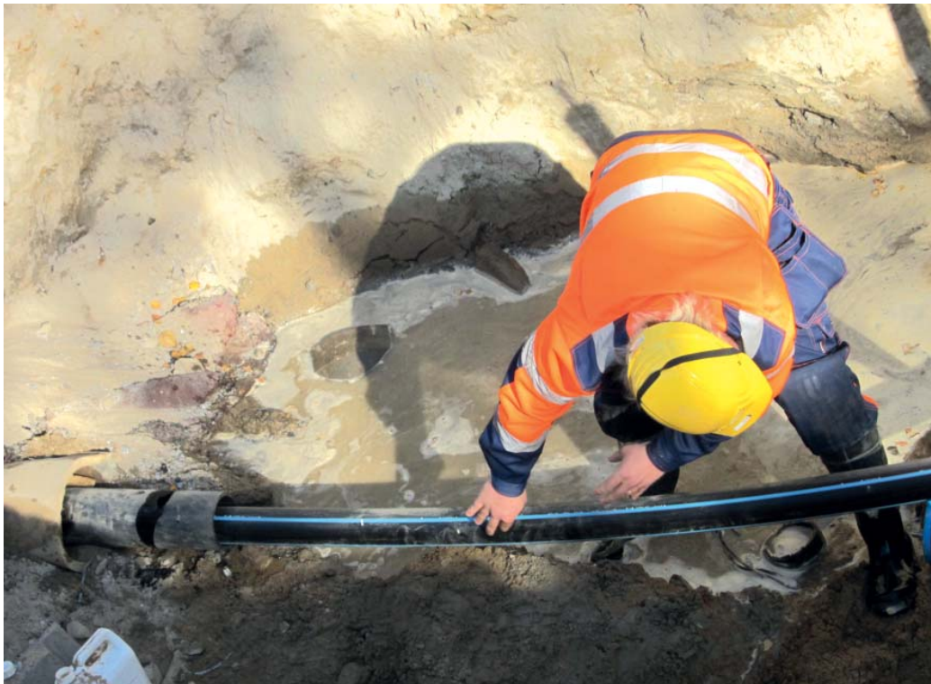
Vesijohtoa saneerataan Ruukissa. Tuomo Soukka sujuttaa vanhan putken sisään uutta muovista vesijohtoa.
