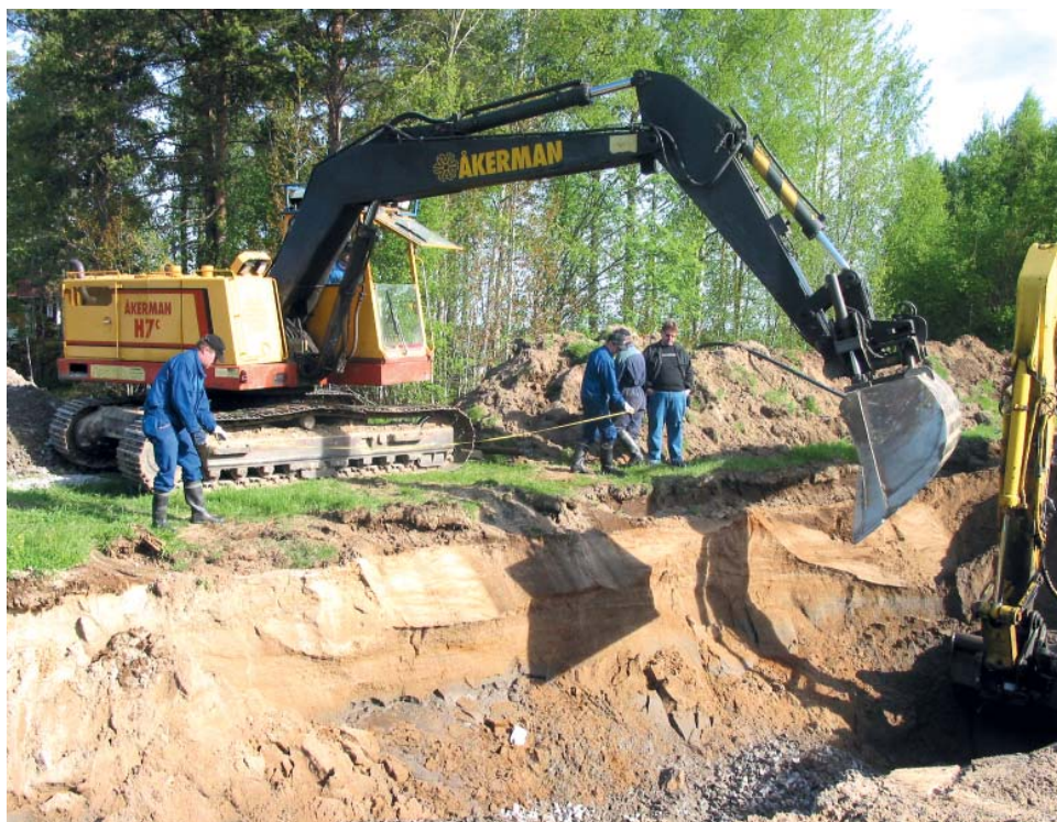
Tienalitusta kaivamassa. Työssä tarvitaan välillä mittaakin.
