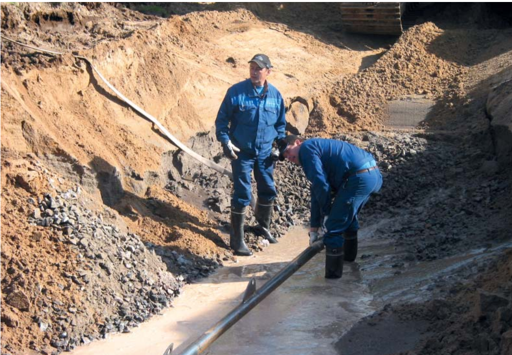
Vesijohdon tienalitusta rakentamassa Timo Haapala ja Jarkko Häkkilä.
