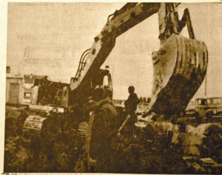
YLEISNÄKYMA Siikajoen vesijohtotyömaalla
