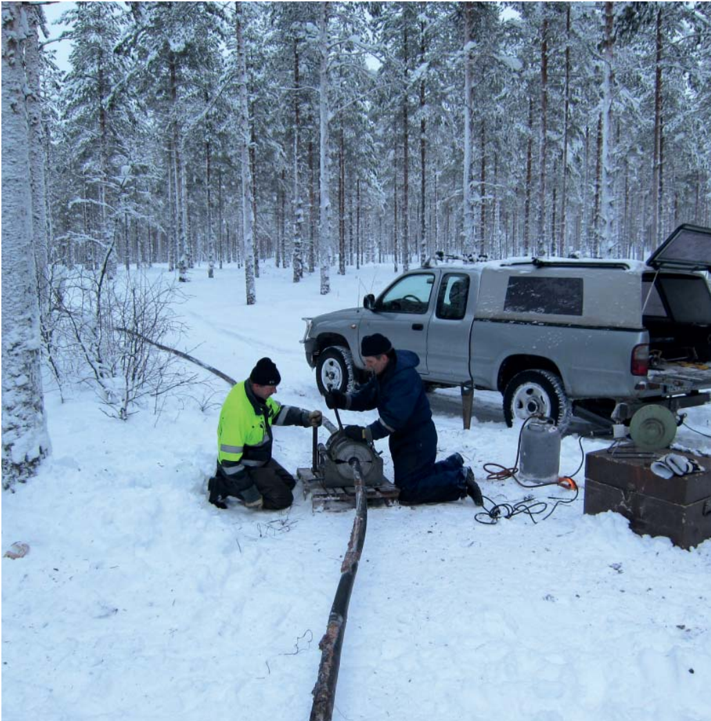
Vartinvaaran koepumppaus alkaa. Kuvassa paineputkea hitsaamassa Raimo Sarjanoja Pohjois-Pohjanmaan Ely-keskuksesta ja vesiyhtiön Matti Honkamaa.
