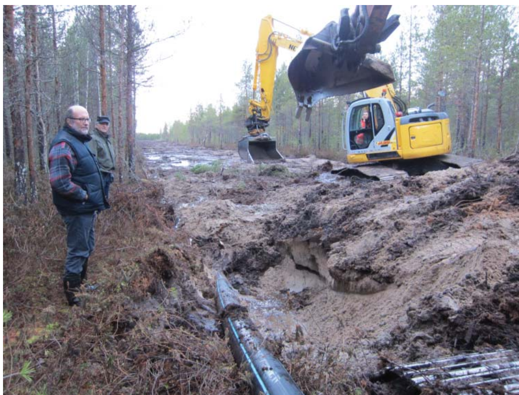
Raimo Lampi ja Aarne Miettunen Vartinvaara-Liminka -vesijohdon rakennustyömaalla.
