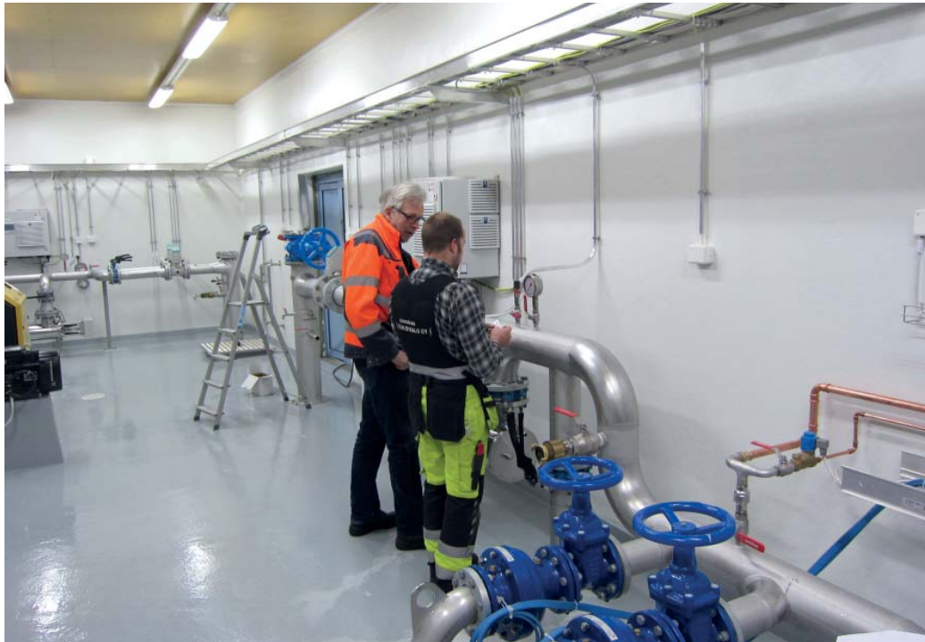
Vartinvaaran vedenkäsittelylaitosta rakennetaan. Työmaalla Hannu Kähkölä ja Kari Kuusisalo Oy:n sähköasentaja Mikko Junttila.
