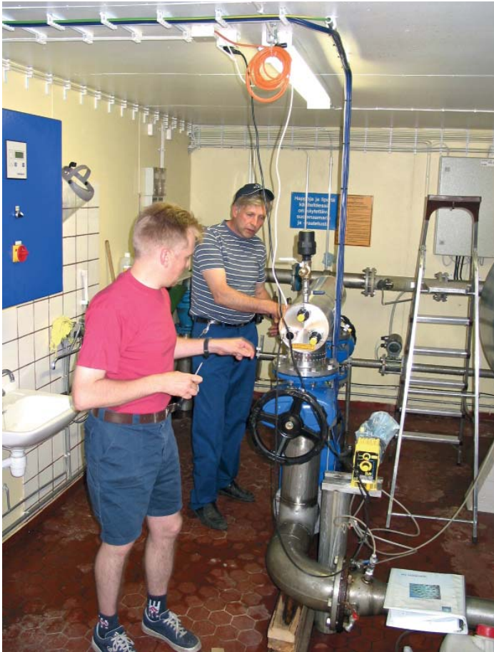
Koivula 1 -vedenottamolle uv-sterilisaattoria asentamassa Hyxo Oy:n asentaja Mika Passila ja Hannu Kähkölä.
