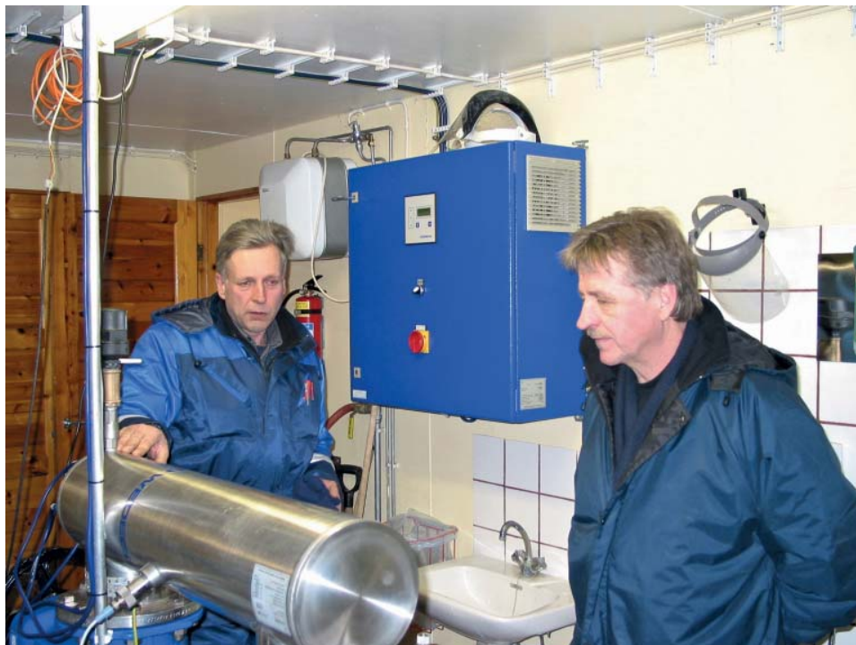
Hannu Kähkölä ja Aarne miettunen tarkastamassa uv-sterilisaattorin toimintaa Koivula 1-vedenottamolla
