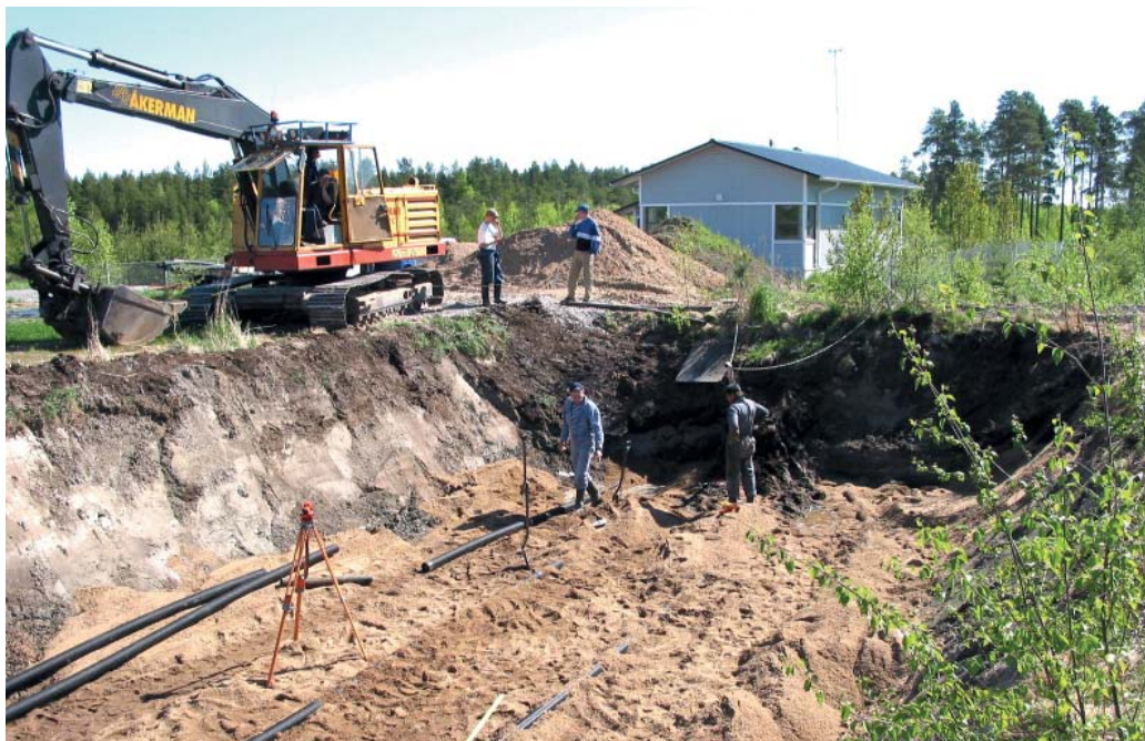
Siikajoen jätevedenpuhdistamon lietealtaan kunnostus.
