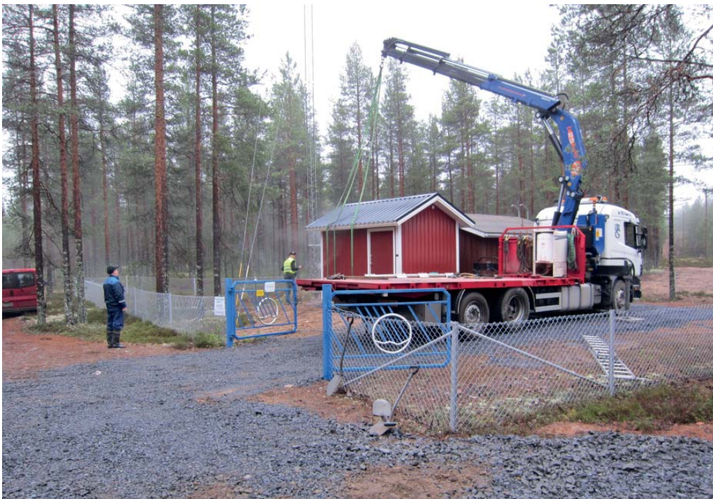
Vartinvaaran vedenottamolle asennetaan varavoimalaitesikköä.
