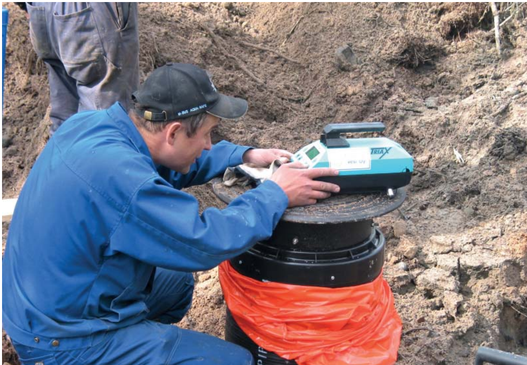
Viemäryömaalla putkilaseria asentamassa Timo Haapala.
