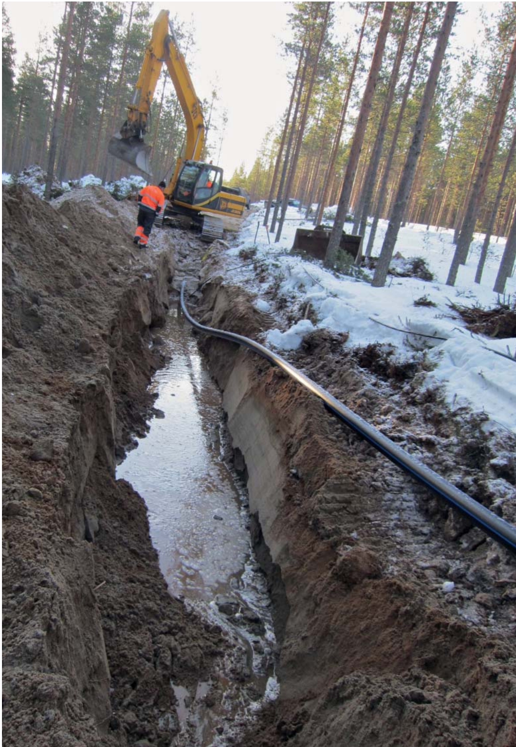
Vesijohtoa rakennetaan Vartinvaarassa.
