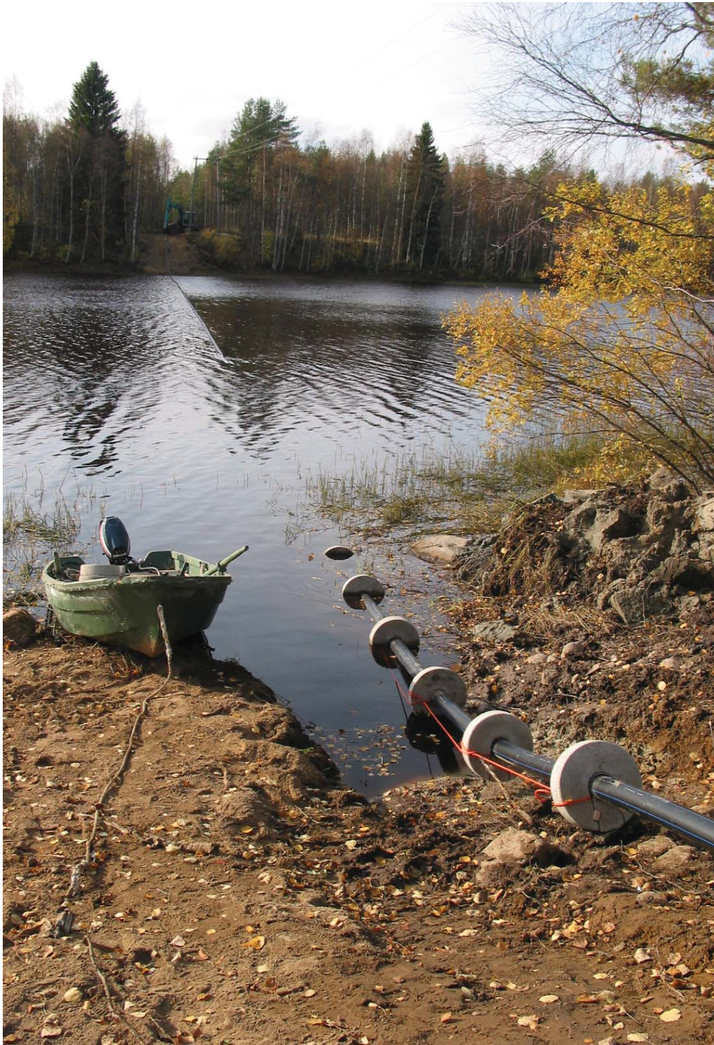
Paineviemärin joenalityksen rakennustyömaa Lahtirannalla Revonlahdella.
